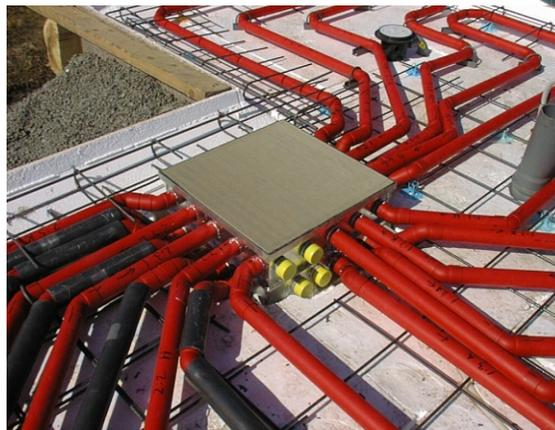
Le boîtier de chauffage est encastré dans la dalle de plancher et possède un couvercle amovible pour l'accès facile.
