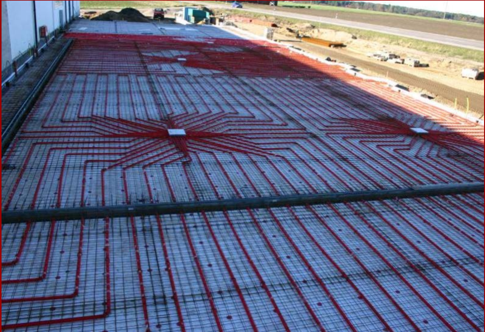
2" System Ready for Pour
