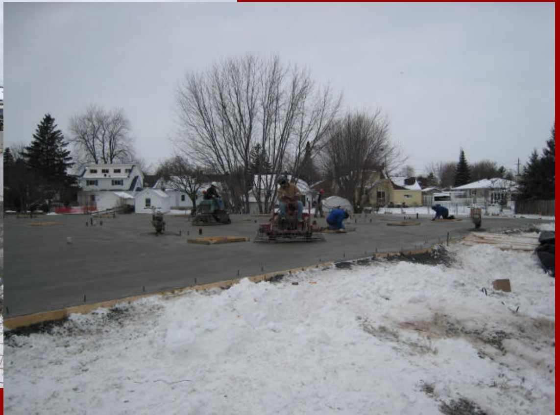
Pour and Finish Concrete
